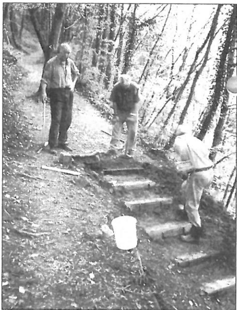
Die Verlegung der Stufen kostete viel Schweiß.
