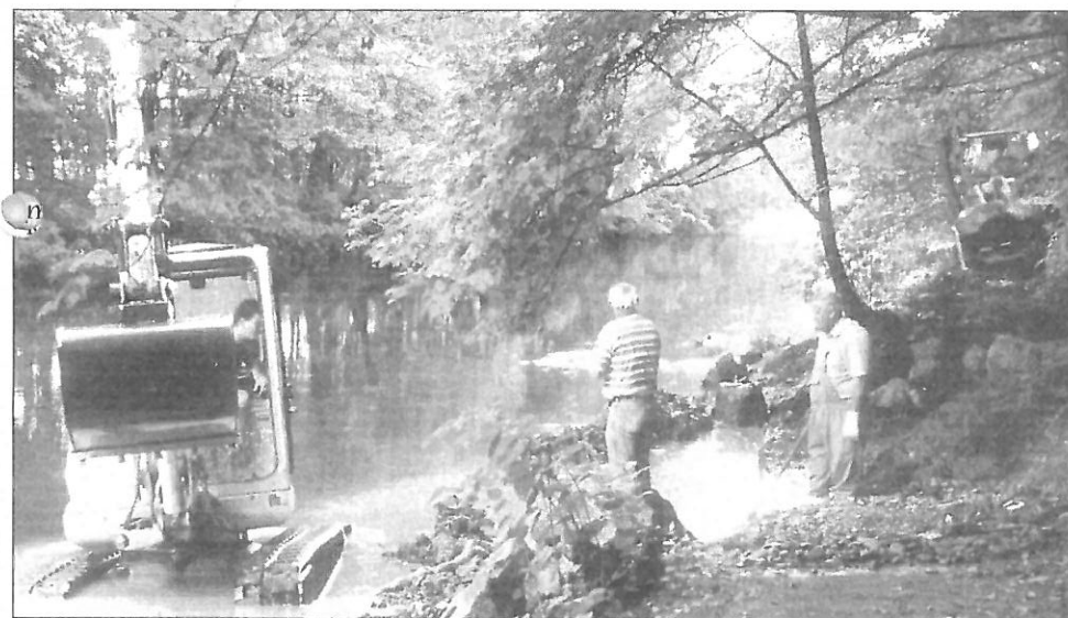
Reparaturarbeiten am Wupperufer in Zusammenarbeit mit dem Tiefbauamt und dem Unternehmen Flocke.
