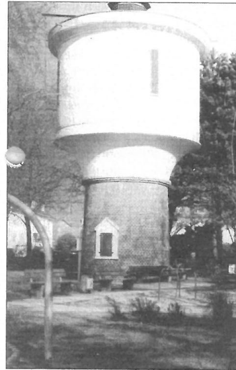
Wasserturm Bergisch Neukirchen neben dem ehemaligen Rathaus.
