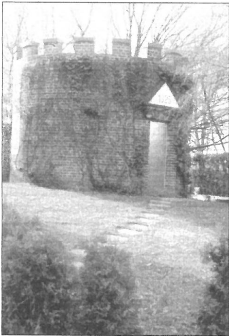
Ehemaliger Wasserturm Pattscheid-Romberg.
